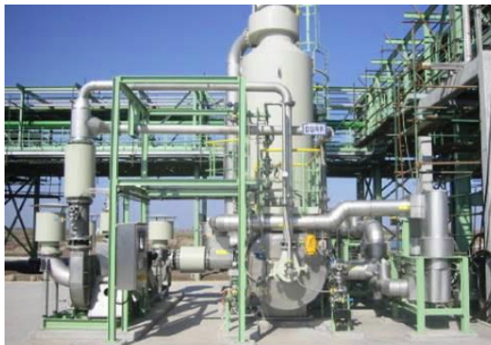
图3-12某化工基地聚酯尾气直燃式热氧化炉应用
